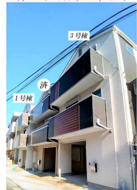
★外観写真(平成31年1月撮影)
